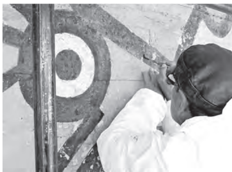
► Reintegración del color sobre el muro. Fotos: cortesía DGPU.
